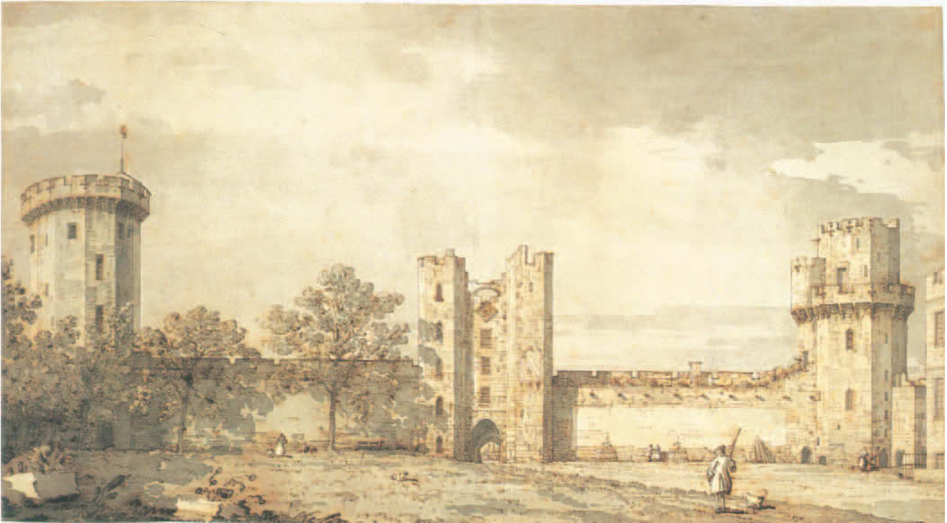
37 CANALETTO (Giovanni Antonio Canal) Italien, 1697–1768 Warwick Castle: Die Ostfront vom Hof aus gesehen
